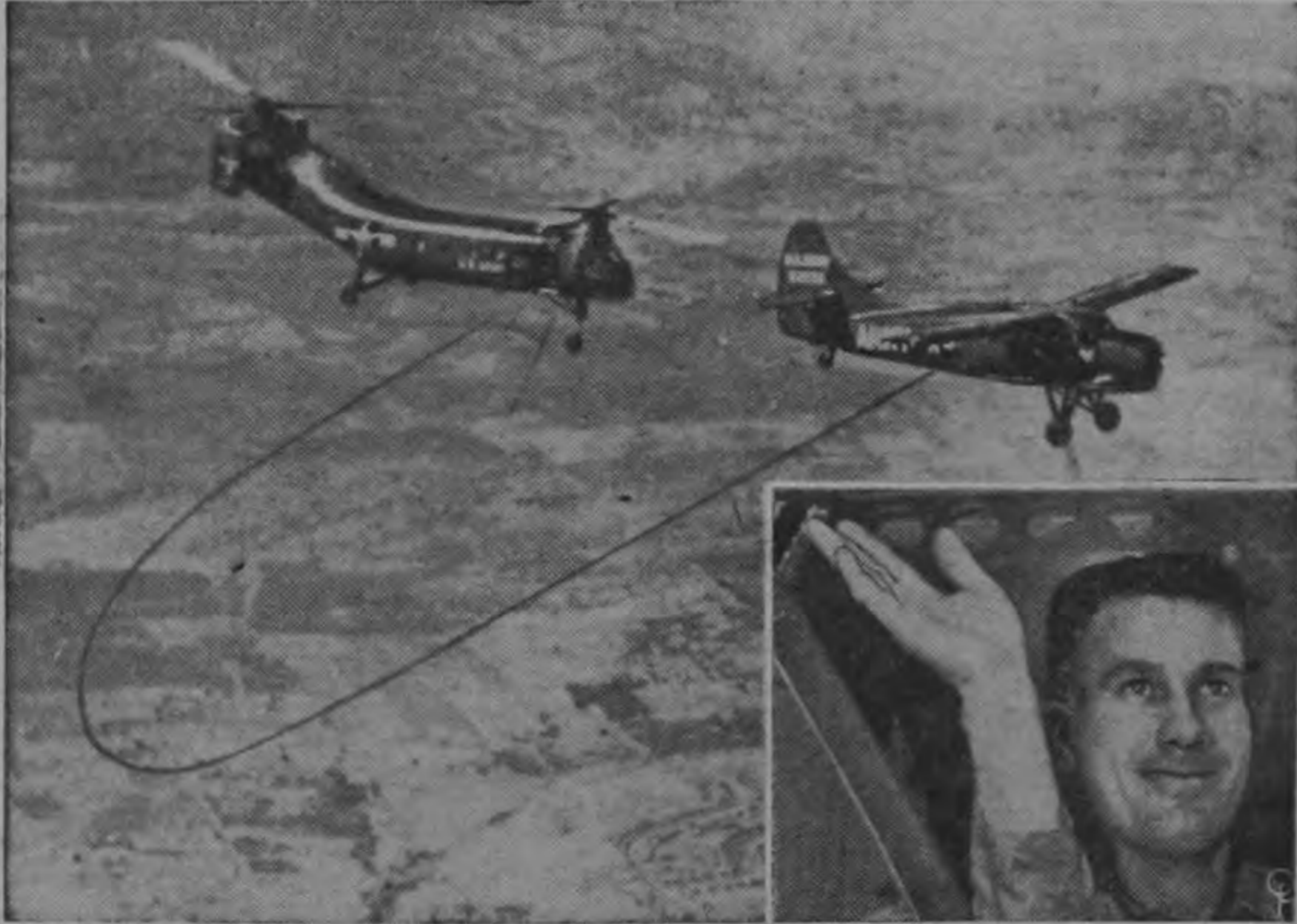
El helicóptero de carga ligera H-21 toma combustible a 5.000 pies de altura al acercarse a la terminación de su vuelo sin escalas de 2.610 millas desde San Diego, California, a Washington. El helicóptero realizó la jornada en 31 horas, 44 minutos. Otras dos tomas de combustible en el aire se hicieron durante el viaje. (Insertado) El Capitán James E. Bowman, saluda desde la cabina después de aterrizar junto al edificio Pentagon. En la tripulación había otros dos hombres. (INP)
